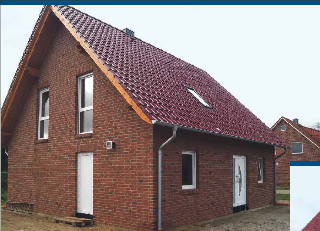
Dieses Einfamilienhaus in Wienhausen / Oppershausen erwartet die Besucher in der Straße „Im Hagen 11“
